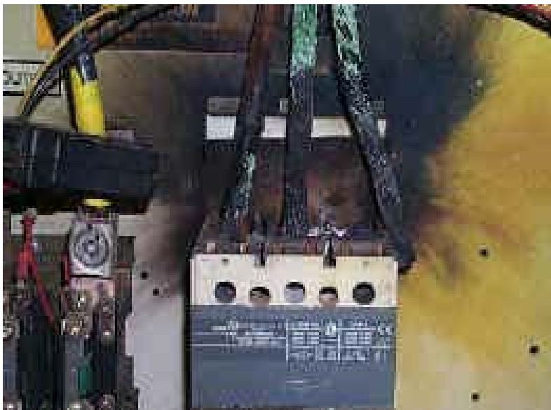
ภาพแสดงตัวอย่าง ผลการเกิดการอาร์ค เนื่องจากหน้าสัมผัสด้านอินพุตหลวม ซึ่งทำให้อุปกรณ์เสียหายได้
